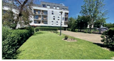
GARGES-LES-GONSESSE. Dans résidence récente et sécurisée un beau F3 (59m 2 ) totalement équipé. Entrée avec rangements, WC, salle d'eau, séjour, cuisine séparée et équipée, 2 chambres. Place de parking. Faible charges. - 205 000 €
