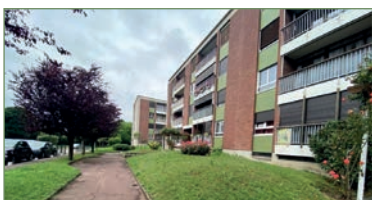
GARGES-LES-GONÈSSE. Dans une résidence fermée, sécurisée et très recherchée sur Garges, nous vous proposons ce beau F4 d'environ 81 m 2 qui se compose : d'une entrée avec placard, d'un séjour avec balcon, une cuisine séparée, 3 chambres, salle de bains, WC séparé et un dressing. Ce bien est complété par une cave et une place de parking extérieur. - 177 000 €
