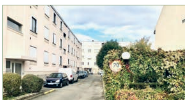
STAINS. beau F4 82m 2 Rue Jean Durand dans une résidence privée et sécurisée construit en 1956. Situé au dernier étage, composé ainsi: Une entrée ouverte, cuisine spacieuse, séjour lumineux, dégagement, 3 chambres, salle d'eau et WC séparé, loggia fermée. Vous disposez d'un box fermé et sécurisé ainsi qu'une cave. Faible charges - 180 000 €
