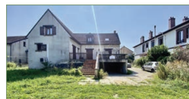
GARGES-LES-GONSESSE. magnifique pavillon de 180m 2 secteur de la LUTECE. Rez-de-chaussée: Entrée, double séjour, cuisine, salle de bains, chambre. 1er: Entrée, buanderie, WC, cuisine avec espace à manger, WC, salle de bains, 3 chambres. Le rez-de-chaussée avec travaux. Pompe à chaleur. Sous-sol total. Le tout sur une parcelle de 870m 2 - 535 000 €
