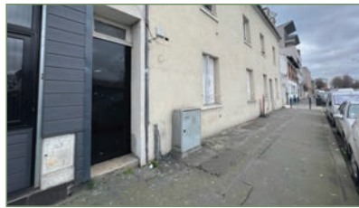
STAINS. F2 proche CARREFOUR d'une superficie de 27 m 2 . Composé ainsi : entrée, séjour avec cuisine ouverte, salle d'eau, WC. Faibles charges. 99 000 €
