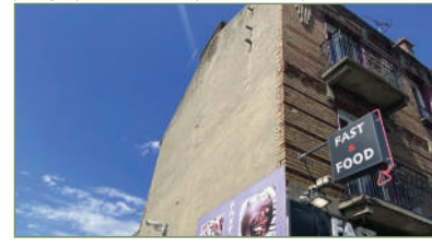
DRANCY. En centre ville, dans une rue commerçante, nous vous proposons un immeuble de 2 étages, au REZ DE CHAUSSEE, 2 commerces loués (restauration), 2 appartements par étages et 2 duplex en fond de cour. 5 appartements vides non loués et entièrement rénovés du sol au plafond. L'intérieur de l'immeuble, sols, murs, boîtes aux lettres, escalier et local poubelles rénovés également. A VOIR D'URGENCE. 1 250 000 €
