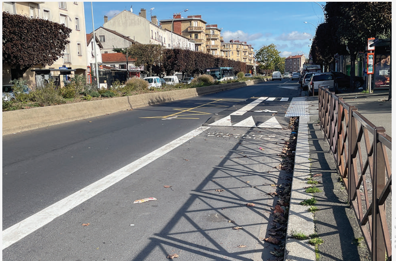
Exemple d'aménagement transitoire sur la RD29 avec la création d'une nouvelle piste cyclable
